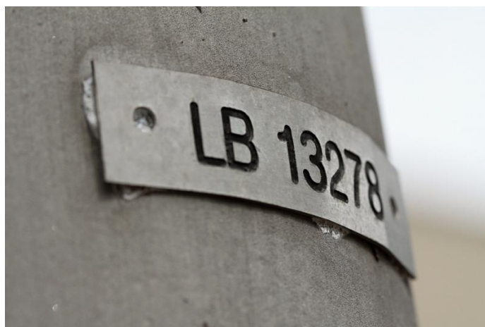
Příklad označení sloupu veřejného osvětlení
